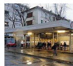
La pensilina dell'autostazione
